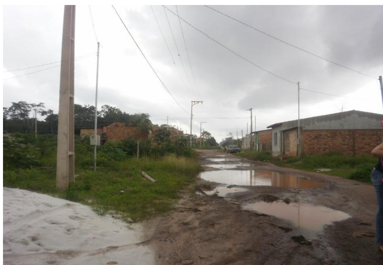
Figura 15: Ocupação Luz Divina, situada na Vila dos Cabanos, apresenta ruas em péssimas condições.
