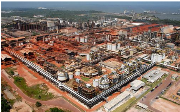
Figura 22 - Vista do Complexo Industrial da Alunorte
