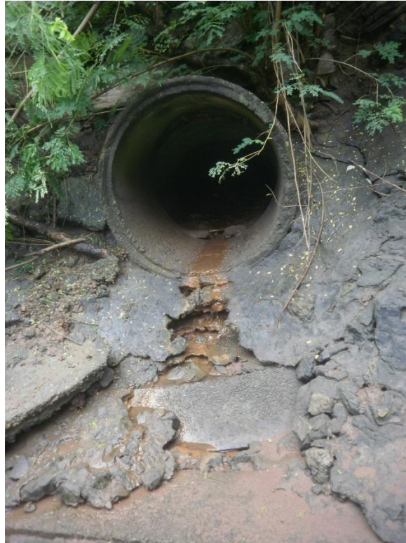
Figura 17: Tubulação liberando efluentes urbanos, in natura , no Rio Murucupi.
